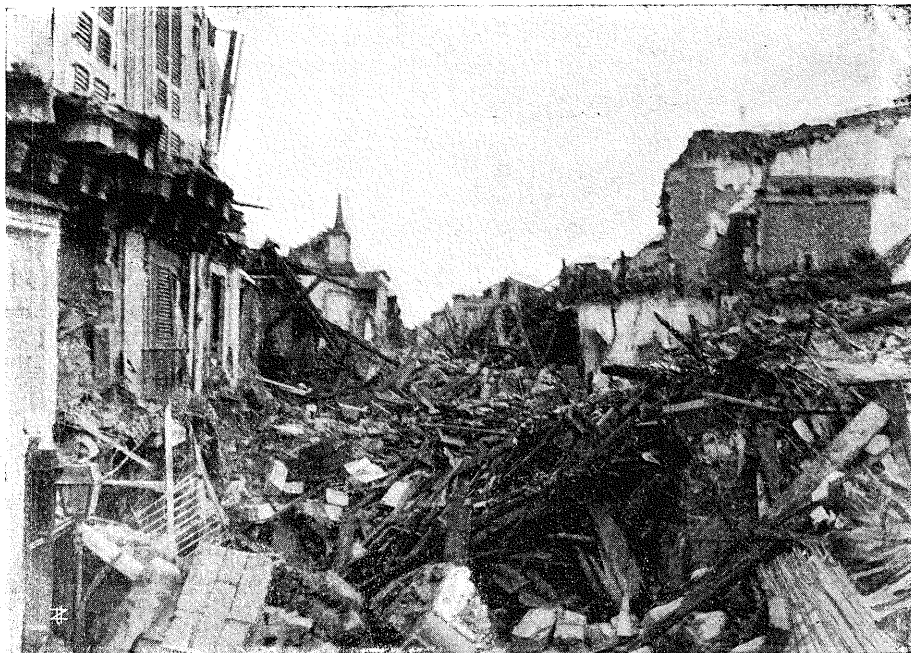
Fig. 3. — Rovine di case con cattiva muratura, tetti e solai non incatenati (Messina).
